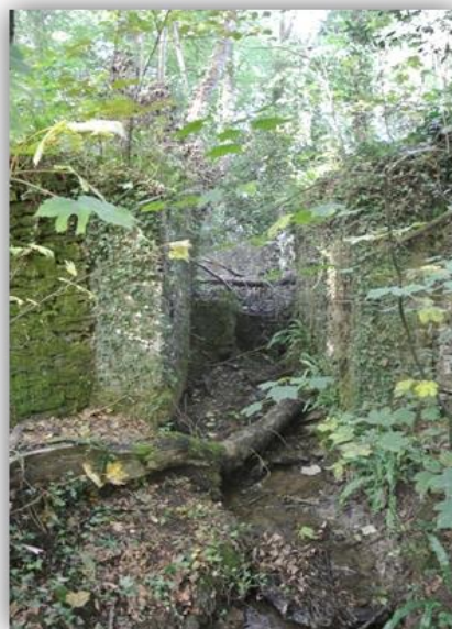
Fig. n°9 : Le mur de la retenue sur le ruisseau de la Noue. Le chemin ancien passait cette retenue sur un pont avant de se diriger vers la Pannetière
