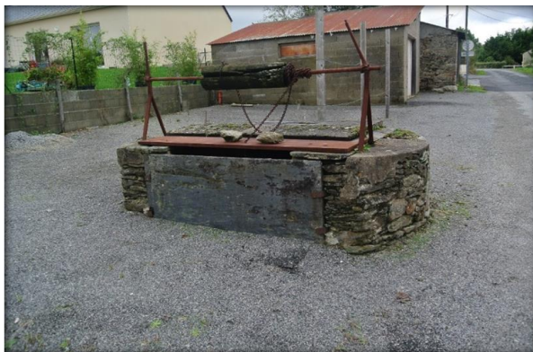
Fig. n°26 : Plaques de schiste sur un puits à la Haute Gournière
