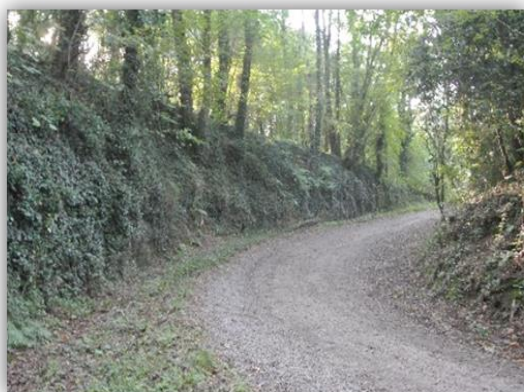
Fig. n°16 : Chemin en lacet descendant vers le village de Verrière. C'est celui qu'empruntent habituellement les promeneurs pour descendre vers les ruines du village. Il fut creusé au moment de la construction du viaduc
